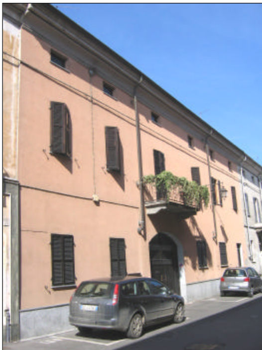
FIG. 78 –Edificio sito in via Tournon n°18A–20. Fotografia di Simone Panti.
