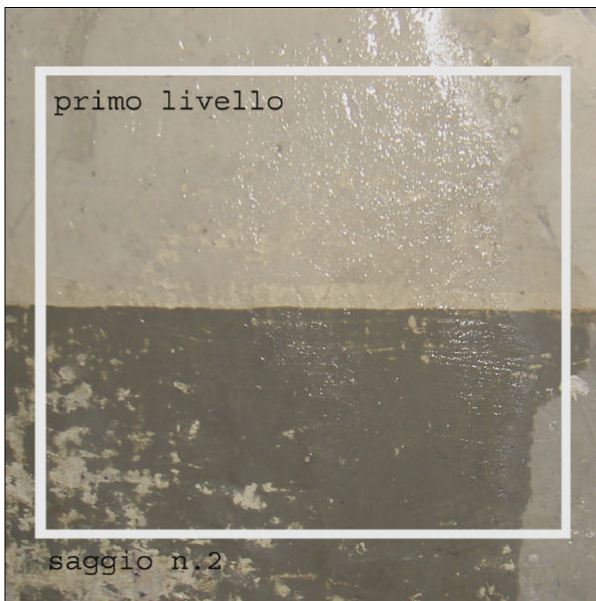
Fondo di esecuzione del saggio: Pareti , zoccolatura
