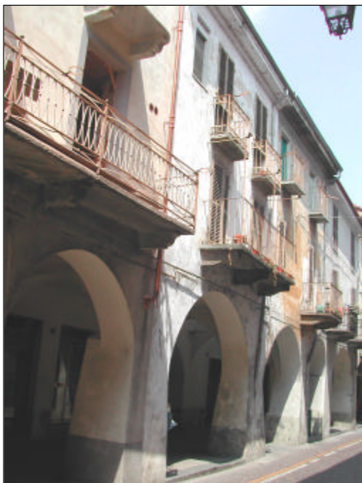
FIG. 77 – Edificio sito in via Mazzini n°100. Fotografia di Simone Panti.
